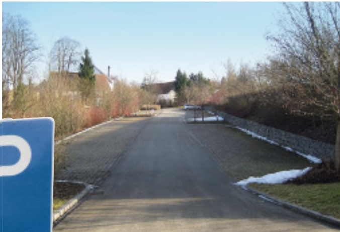
Seit 25 Jahren: Längsparkflächen auf dem Stellplatz in Viechtach.
